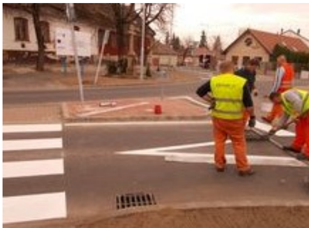
3. ábra – Gyalogátkelőhely létesítése
